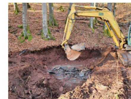
Gefasste Quelle vor der Renaturierung (oben) Rückbau der Quellfassung (unten)
